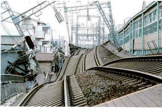
阪神淡路大震災・鉄道被害
