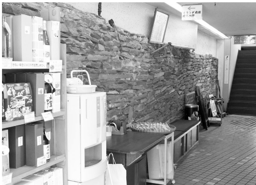
海産物店に残るオランダ商館倉庫の壁
